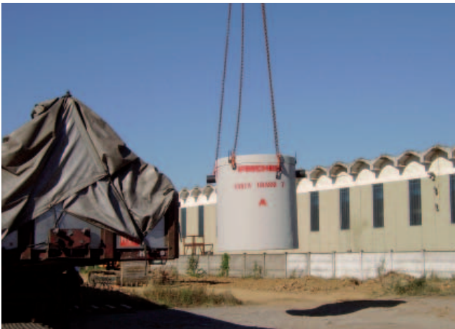
Fasi di movimentazione e posa di vasche circolari
