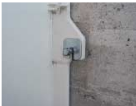
2. Forare, inserire i tasselli ed avvitare non completamente. Appendere la bocca di lupo.
