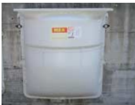
10. Il montaggio è ultimato.
