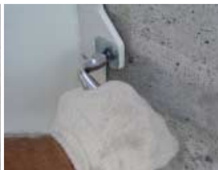
3. Avvitare completamente al muro.
