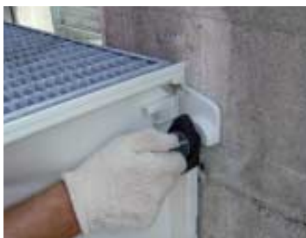
8. Inserire le manopole di regolazione ed avvitare parzialmente.
