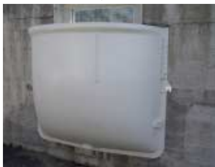
4. La parte inferiore della bocca di lupo è fissata.
